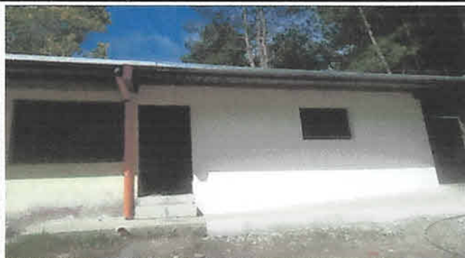
FINALIZACION DE AMPLIACION Y CONTRUCCION DE COMEDOR
