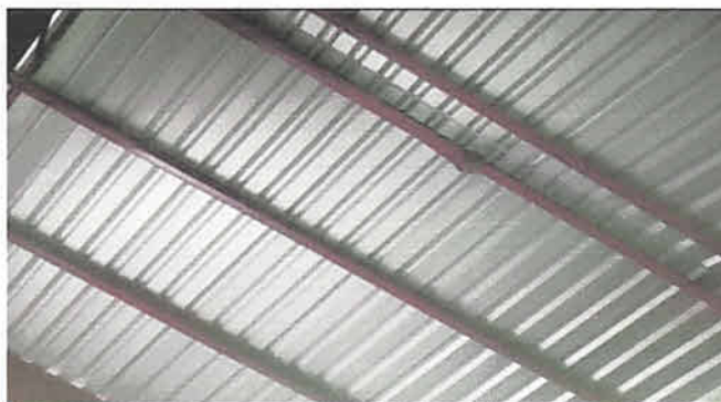
CAMBIO DE TECHO Y MANTENIMIENTO DE TECHADO DEL SALON DE CLASE
