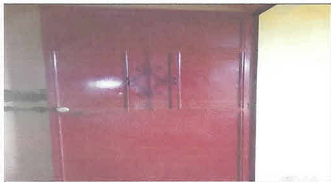
MANTENIMIENTO DE PUERTA Y CAMBIO DE CHAPA
